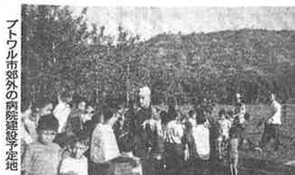
フトワル市郊外の病院建設予定地 院ではな
