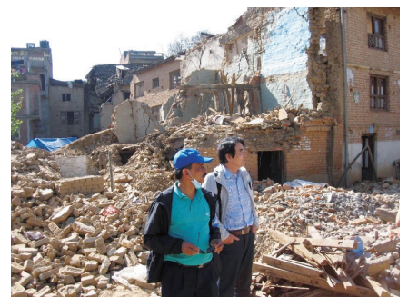
2015年、ネパール地震被災現場
