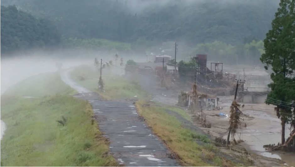
令和2年7月豪雨（熊本県球磨地方）被災者緊急支援活動 球磨村被災状況
