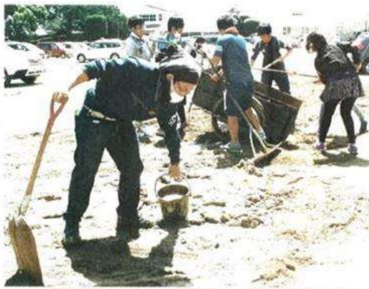
車中泊が続く広安小学校の校庭で、授業再開に向けて整地する学生ボランティア＝4日
