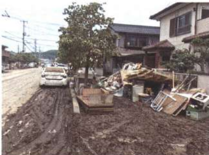
甚大な被害を受けた倉敷市真備町
