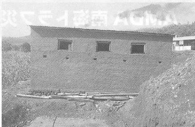
小学校に建設されたトイレ
