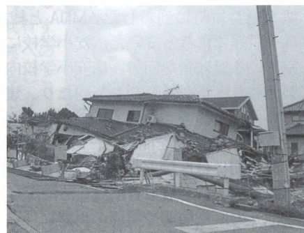
4月15日益城町建物への被害の様子
