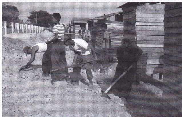
仮設トイレを整備する様子(メティラ市)
