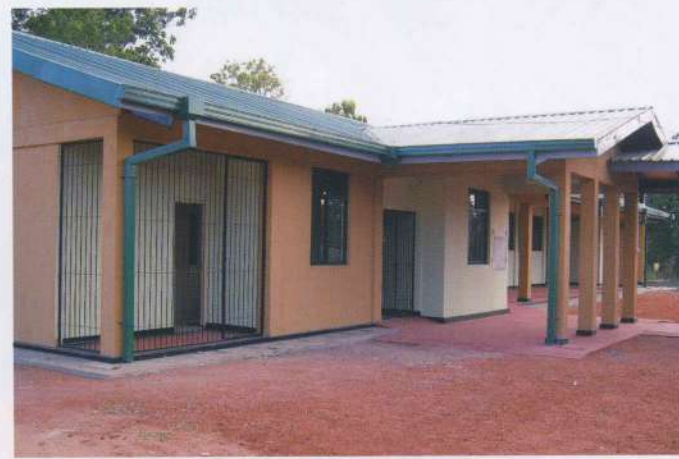
ブーバラサンクラム産科病棟建設
