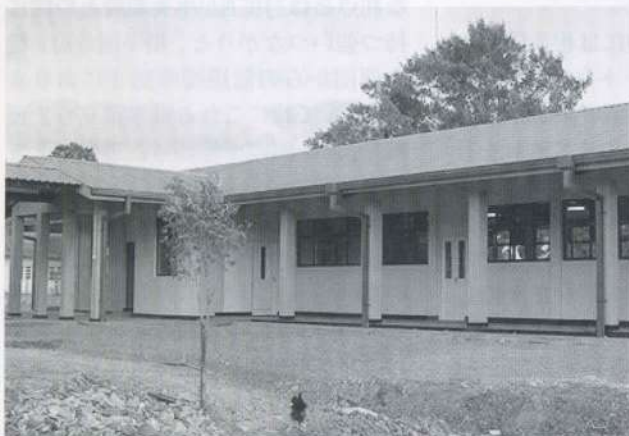
プーバラサンクラムMH（産科病棟）
