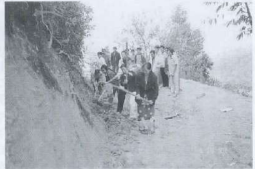
道路の修復方法の実演指導。雨を流す溝を作ることによって雨季でも凸凹ができないことを教授している
