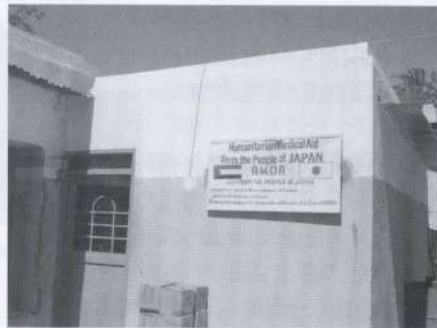
外来病棟に隣接して増設した処置室
