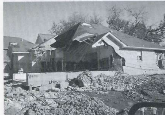
ニューオリンズ市郊外の漁港(上)、棧橋(中)、住宅地(下)被害状況
