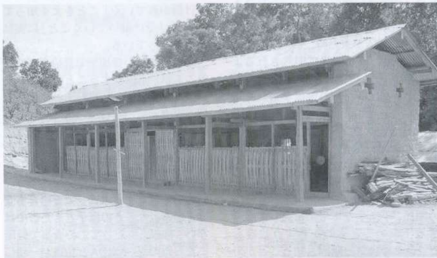
修復した小学校
