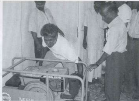
初めて発電機を稼働させる瞬間
