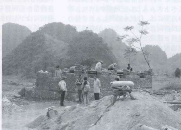
カイ村のヘルスポスト建設が進む
