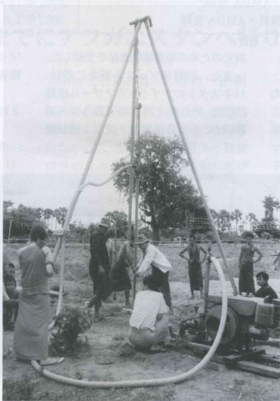
やぐらを組んで深い井戸を掘削
