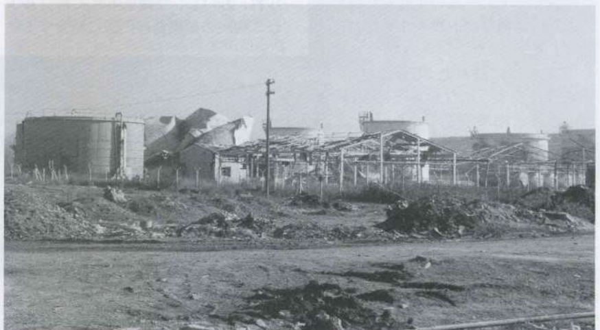
プリズレン近郊(クルーシャ村近く) NATO空爆で破壊されたワイン工場 戦後隣に新しい工場が建てられた
