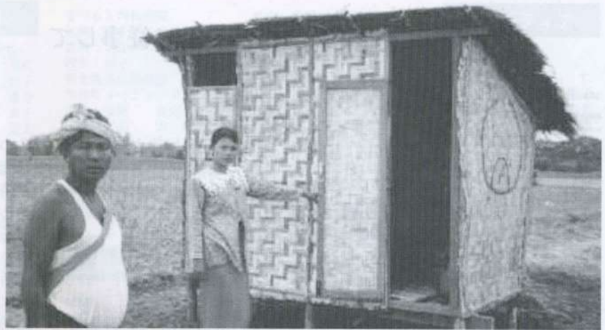
完成した仮設トイレ
