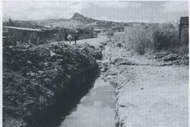
重機を使って掘った部分
