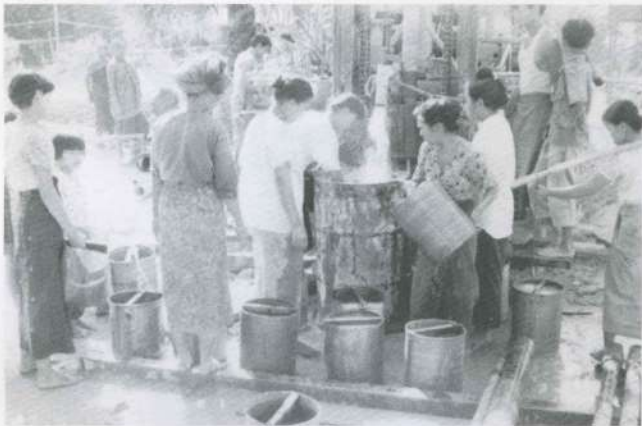
シュエタンサー寺院内の井戸へのポンプ設置完了
