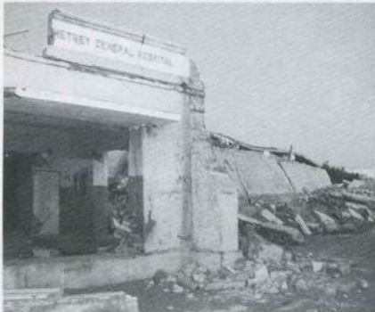
崩壊したブジ市民病院
