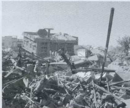
崩壊したアンジャール市場周辺
