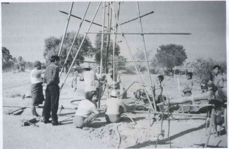
井戸とパイプラインの接続により多くの世帯へ水の供給が可能となる
