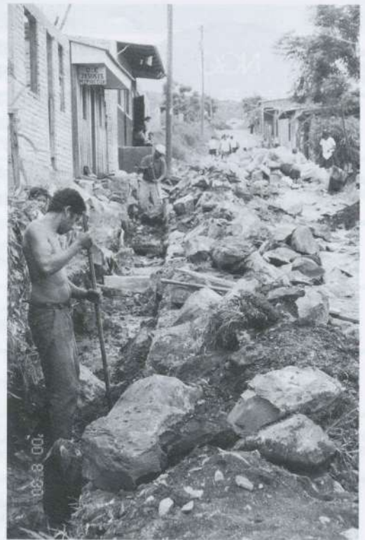
排水溝建設作業をするブロック住民
