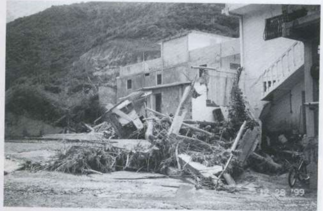
カレ村：鉄砲水による被害
