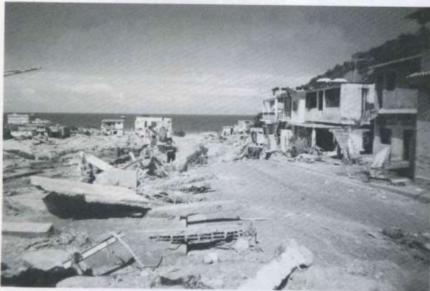
ナイグアタからカムリ・グランデに向かう途中 コンクリの広場陥没
