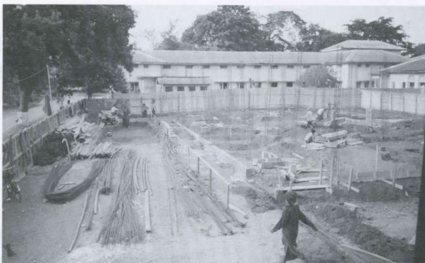
AMDA ミャンマー子ども病院建設現場
