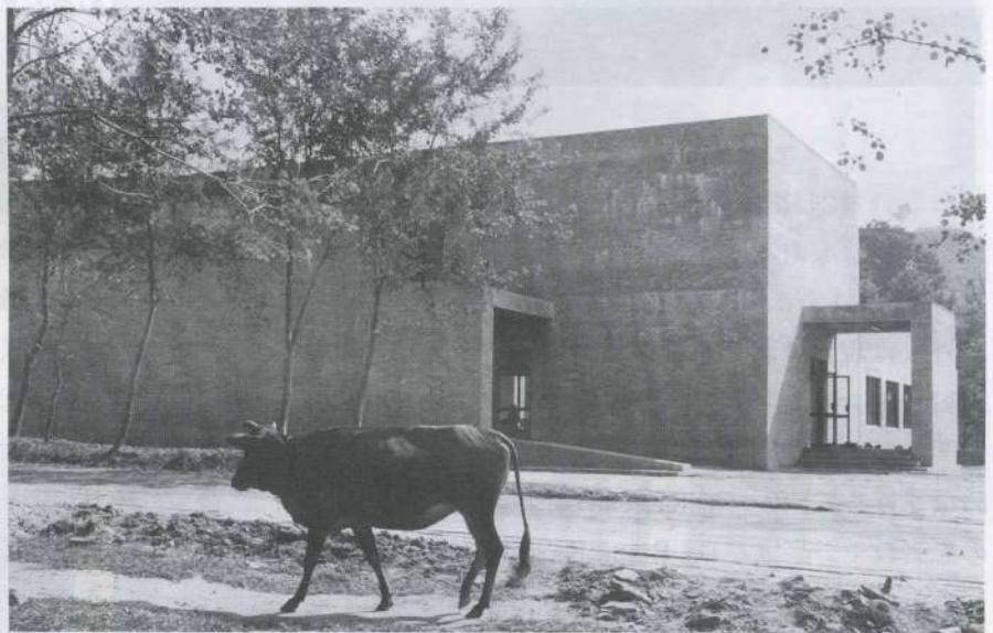
AMDAネパール子ども病院外観
