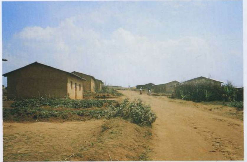
ルワンダ：シェルターとメインロード ビュンバ県の再定住地域60軒の住宅がAMDAによってつくられた
