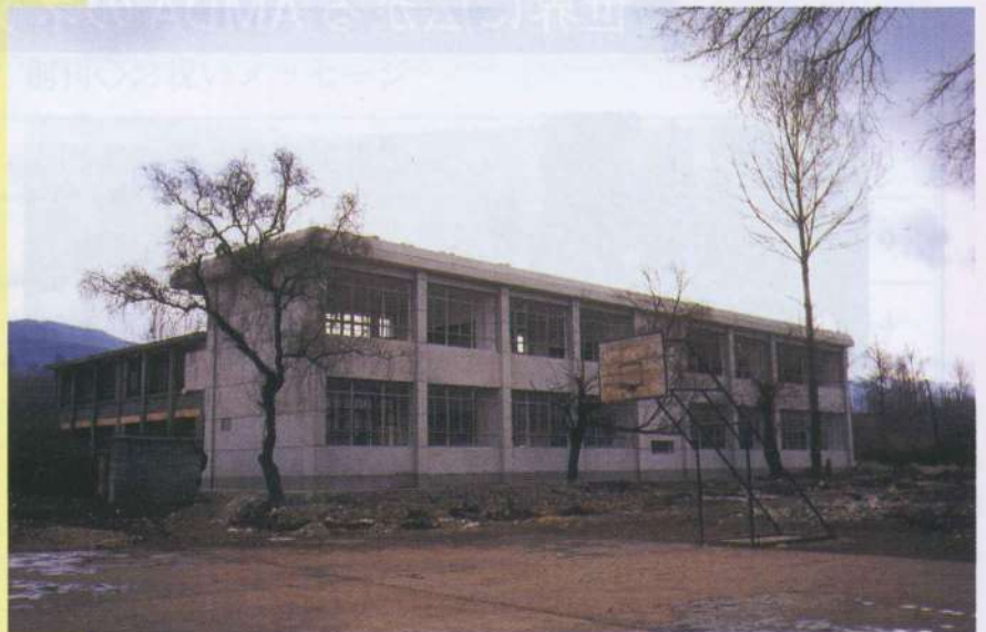
完成した中心完小学校
