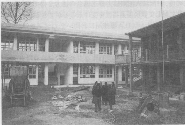
小学校建築現場
