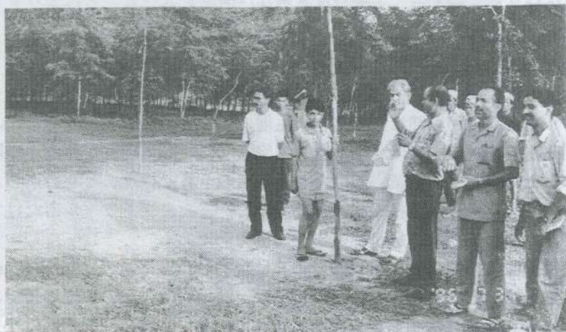
プトワール母子病院の建設予定地
