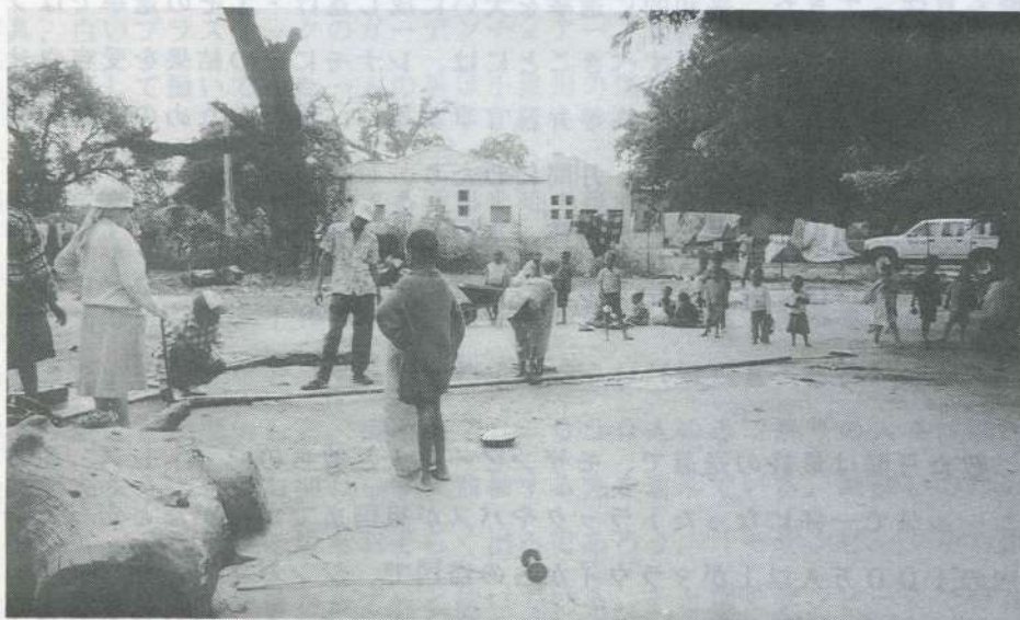
chokwe 地区 Barragem H.C の井戸の取りかえ作業中。
