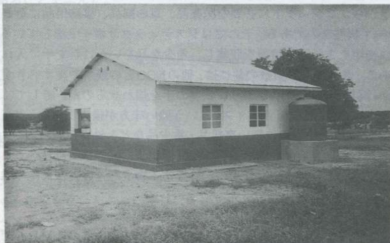
マカラーレのヘルス ポストの建設をAMDA が行う タンクに雨水を貯めて 使う予定である
