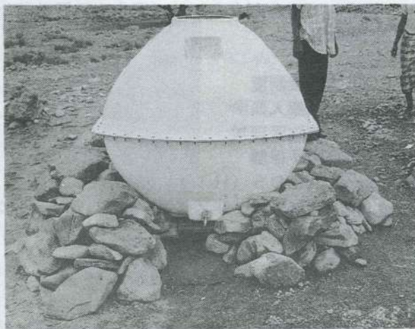
キャンプにおける給水設備
