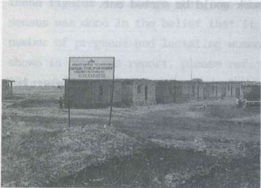
被災民のために建設中の 新しい家
