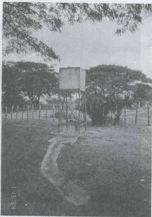
病院内の敷地に作られた 井戸と給水タンク
