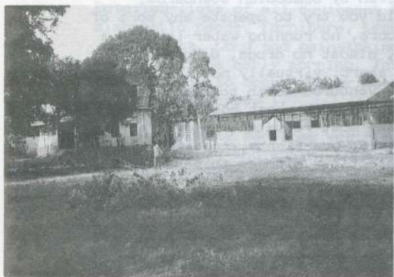
学校敷地内に建設したトイレ （ドゥマリア村）
