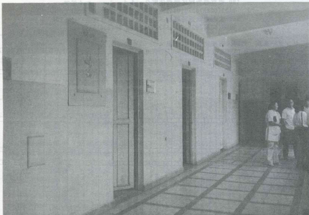
シアヌーク病院 この病棟を修復し精神科病棟7室完成
