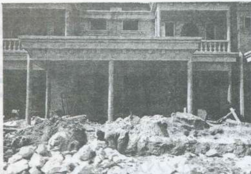
写真-2・建設現場の作業風景
