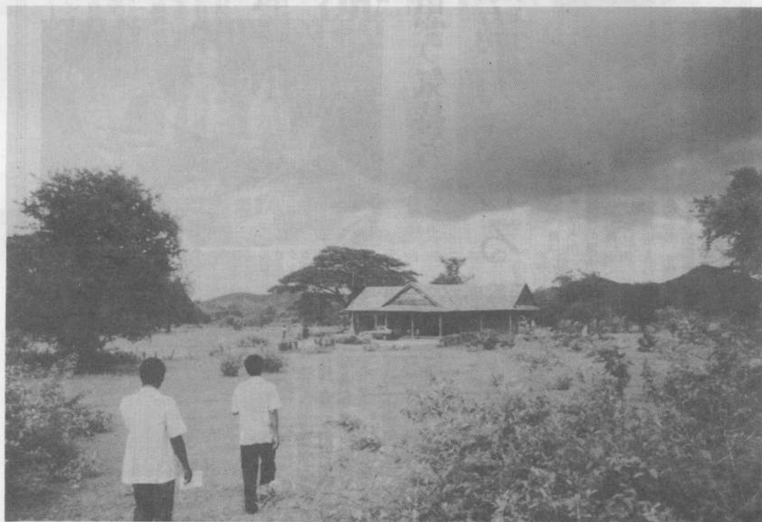
一見平和なプノム・スロッチ郡病院
