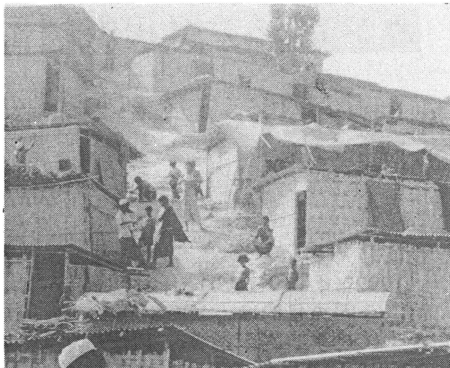
多くのキャンプは斜面に建てられており、雨期が心配だ
