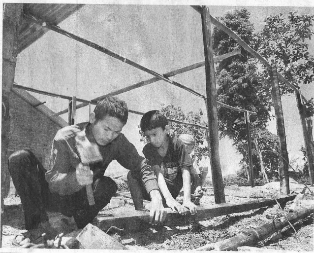
地震で倒壊したがれきの中から廃材を探し出し、雨期を前に急ピッチで家を作る被災者(ネパール・ゴルカ地区のパストラヌ村で3日、望月晃一撮影)
