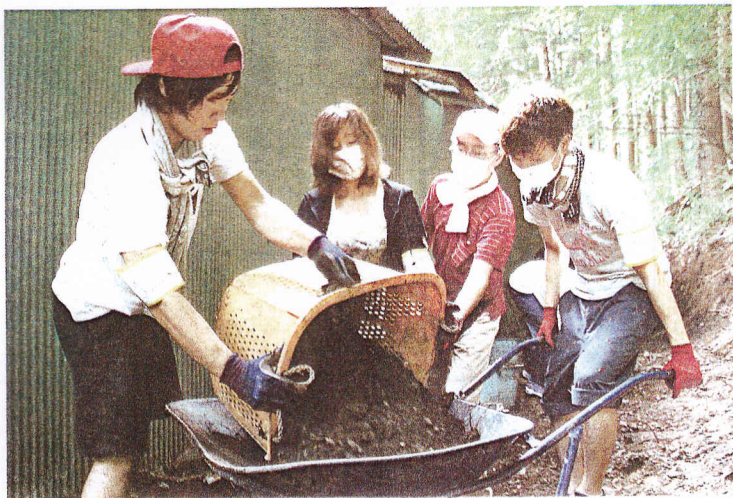
旧桑浜小学校で土砂を片付ける学生たち＝8月25日、宮城県石巻市雄勝町
