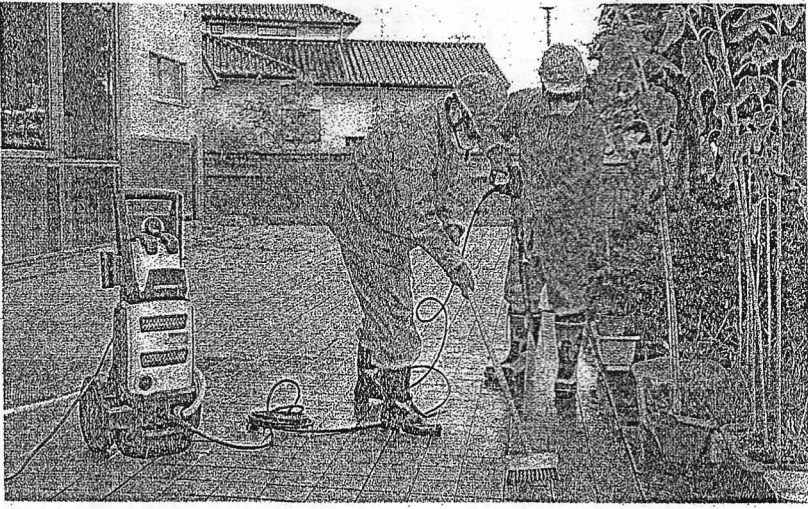
高圧洗浄機で除染作業をする国際貢献大学校のスタッフ。9日、福島県伊達市梁川体育館（公設国際貢献大学校提供）
