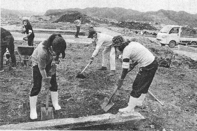
住宅の基礎部分を埋め尽くす土砂とがれきを取り除く学生ボランティアら＝8月26日、岩手県大槌町
