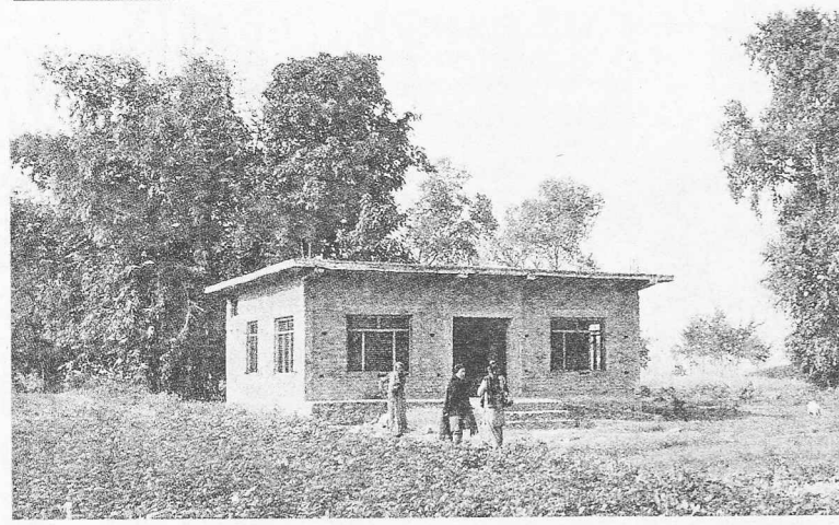
建設中のまま工事が中断していたカマリア行政村の診療所
