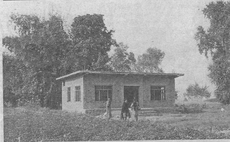
建設中のまま工事が中断していたカマリア行政村の診療所
