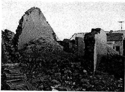
写真7 インド西部グジュラート州で発生した大地震の被害状況
