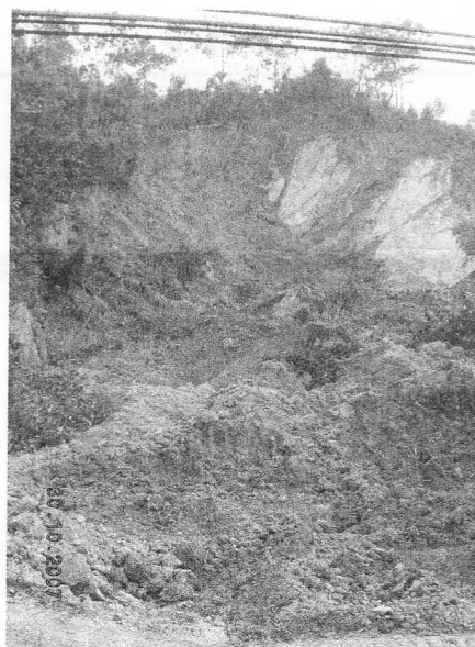
土砂崩れにより完全にふさがれた幹線道路
