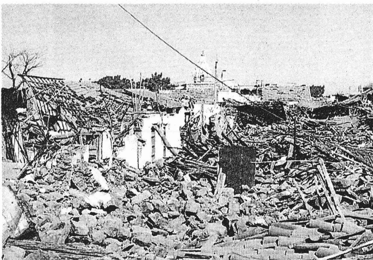
跡形もなく倒壊した建物。地震の被害の大きさを物語るⅡブリジ(AMDA提供)
